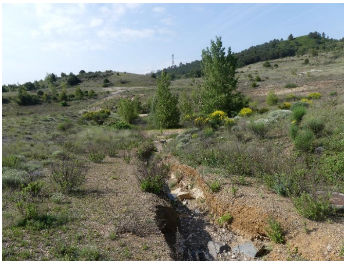
Illustration 19 : Caniveau d'amenée à la mare B2 raviné
