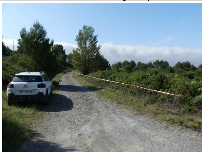
Illustration 39 : Cheminement piéton mis en place dans le cadre des travaux de reprise à venir, le long de la piste d'accès Nord-Ouest
