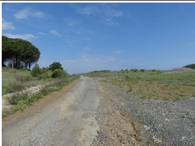
Illustration 13 : Piste de circulation principale depuis l'accès Est en bon état
