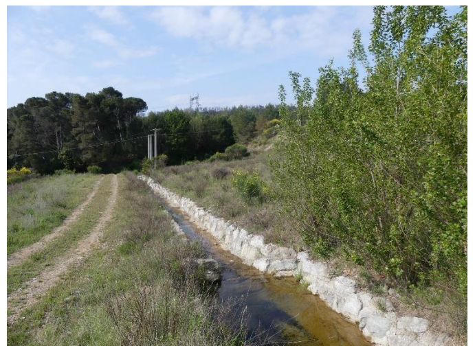
Illustration 30 : Caniveau d'acheminement des eaux pluviales en bon état de fonctionnement
