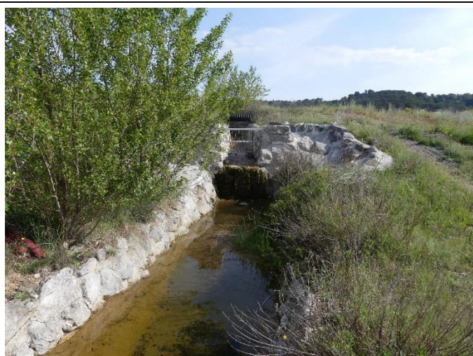
Illustration 31 : Dépôt de sédiments dans le bassin aval du dégrilleur
