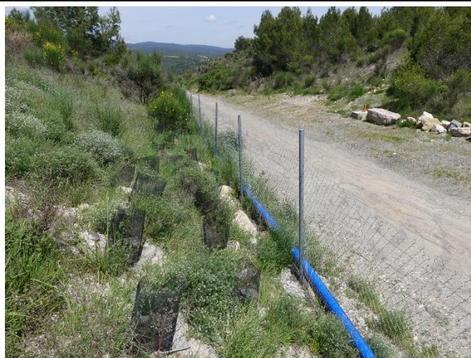
Illustration 12 : Exemple de revégétalisation en cours de suivi. Canalisation de Montredon reprise en 2021 (en bleu)
