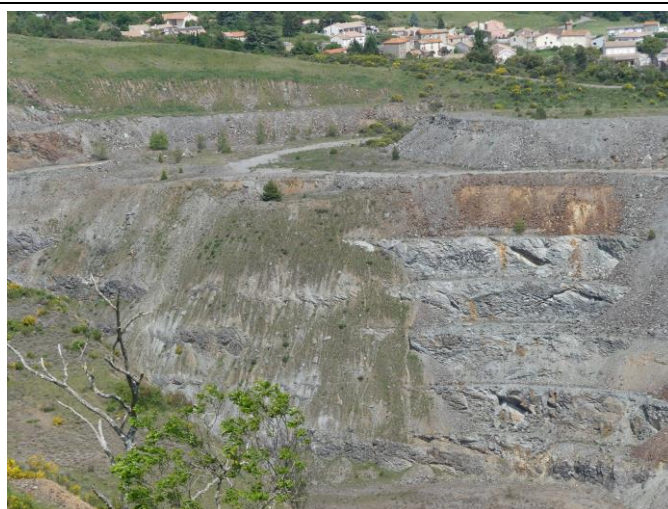
Illustration 58 : Eboulis stabilisé sur les banquettes de la partie Nord-Ouest de la MCO
