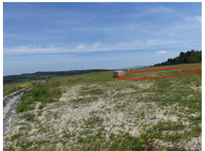
Illustration 4 : Partie sommitale et merlons de protection des drains
