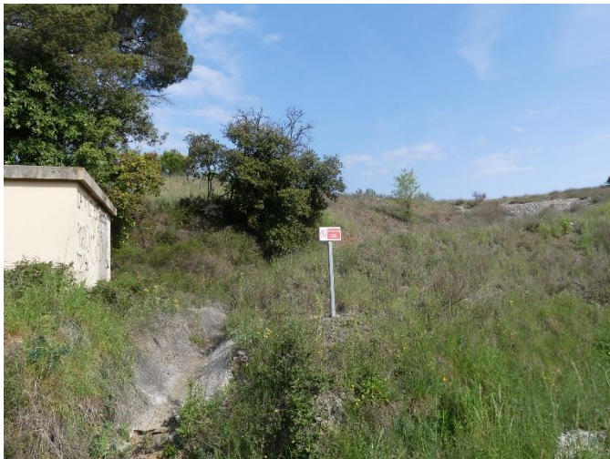
Illustration 27 : Panneau de restriction d'accès en bon état
