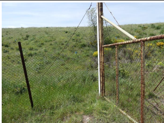
Illustration 53 : Raccrochage provisoire de la clôture de l'ancien portail d'accès
