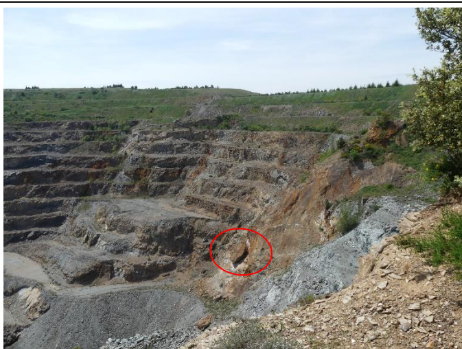
Illustration 57 : Bloc éboulé sur une paroi de la MCO
