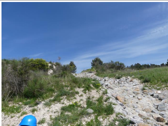
Illustration 9 : Descente d'eau en enrochements bétonnés
