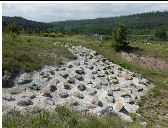
Illustration 42 : Enrochements bétonnés en amont du bassin d'orage, en bon état
